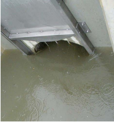
Schieber im Auslauf des Erdbeckens
