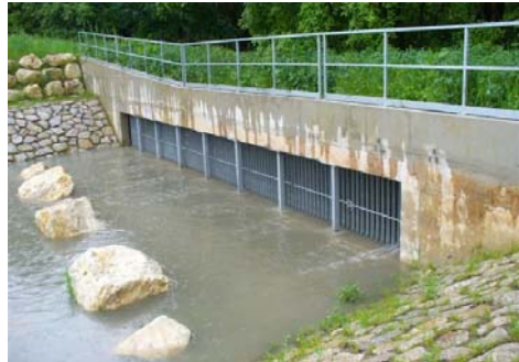
Flussbausteine im Erdbecken
