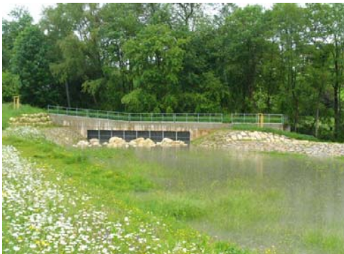
Regenrückhaltebecken Brühl (Erdbecken)
