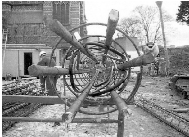
Abbildung 2: Beispiel eines mit Rohrschlangen belegten Armierungskorbs für einen Bohrpfahl
