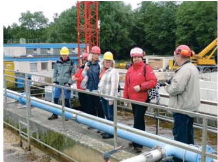
Besichtigung des Umbaus der Kläranlage Bonlanden, Foto: Simone Schwiete
