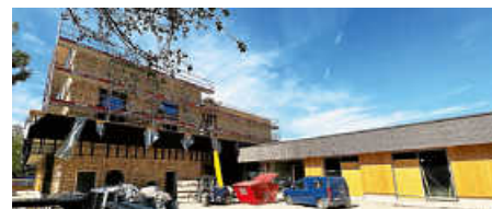
Baustelle Jugendzentrum und GMS-Sporthalle.
