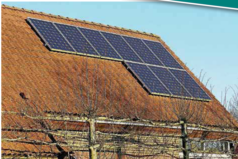
Für die meist kleinen Photovoltaikanlagen der ersten Stunde läuft Ende des Jahres die EEG-Förderung aus. Foto: Pixabay
