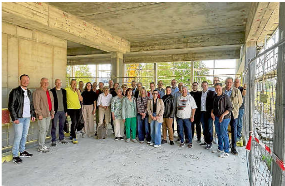
Gemeinderat und Verwaltungsspitze besuchen die Großbaustelle in Bernhausen.
