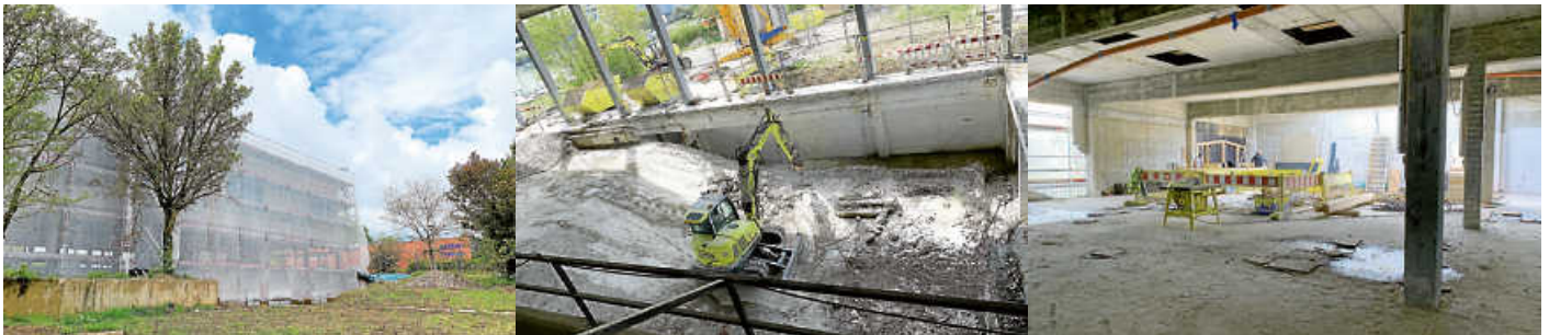
(Von links) Der Blick von „außen“, nach „innen“ (Beckenbereich) sowie ins Obergeschoss.
