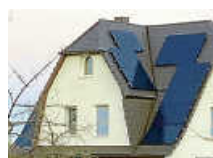
PV-Anlage auf Hausdach.
