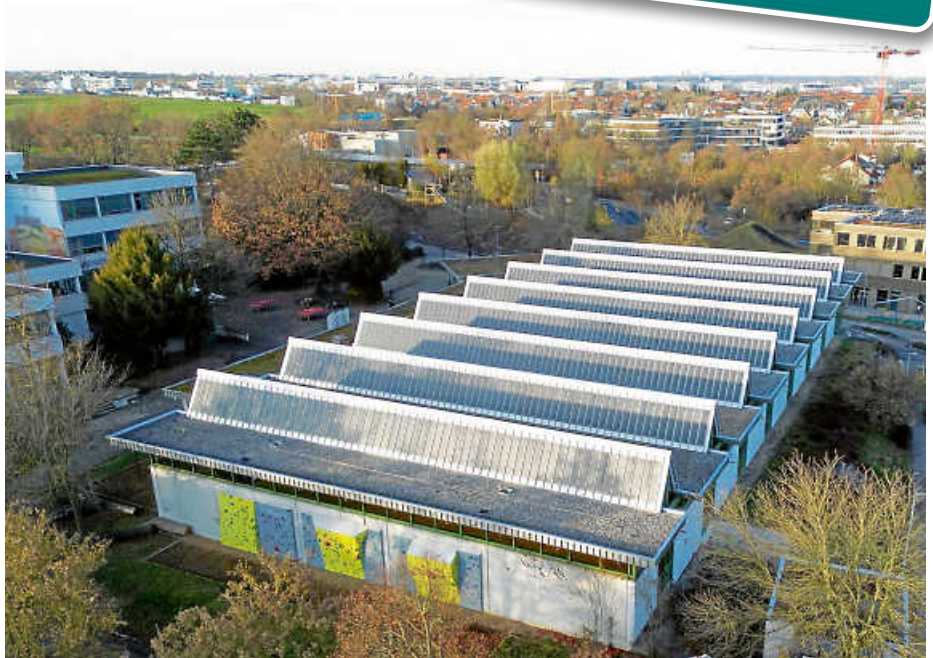
Die neue PV-Anlage auf dem Dach der ESG-Sporthalle.
