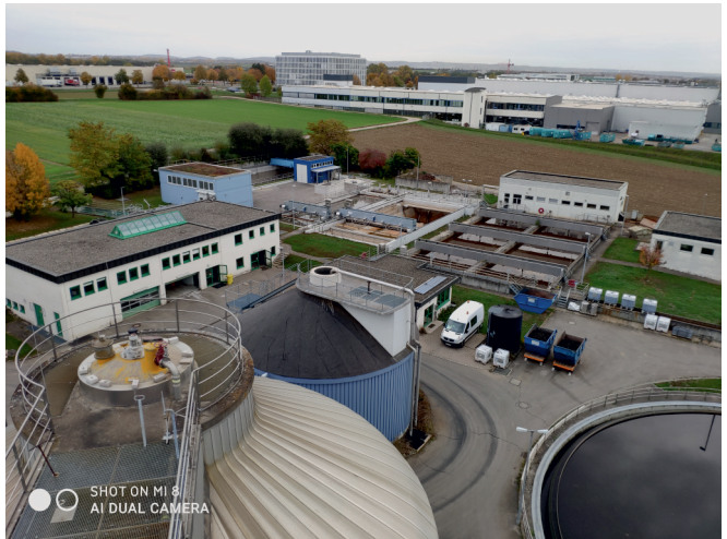
Kläranlage Sielmingen mit Vorklärung, Belebungs- nachklärung, Faul- turm, Foto: Martin May
