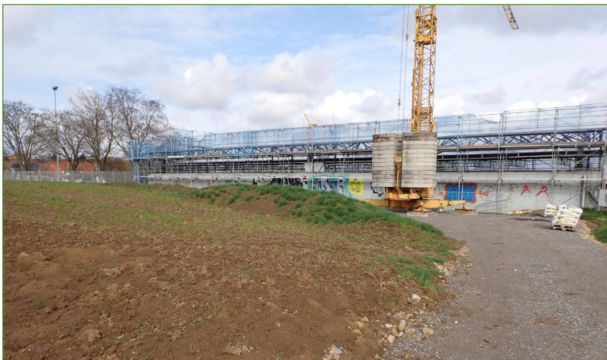
Abbildung 6: Zum Zeitpunkt der Erstbegehung fanden Sanierungsarbeiten an der Stehtribüne des angrenzenden Sportplatzes statt. Das Erdlager am Ackerrand bietet gute Habitateigenschaften für die Zauneidechse.
