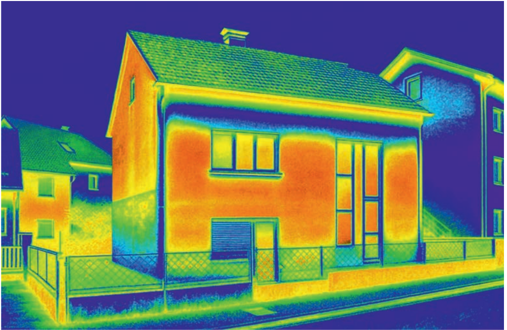
Digitale Wärmebild-Technik im Einsatz: Farbkodierte Thermografie-Aufnahme, wie sie sinngemäß auch in Filderstadt genutzt wurde. Heiße Farben markieren hohen Wärmeverlust an Gebäuden – ein wichtiger Indikator, um energetische Sanierungen gezielt anzugehen. Foto: KI
