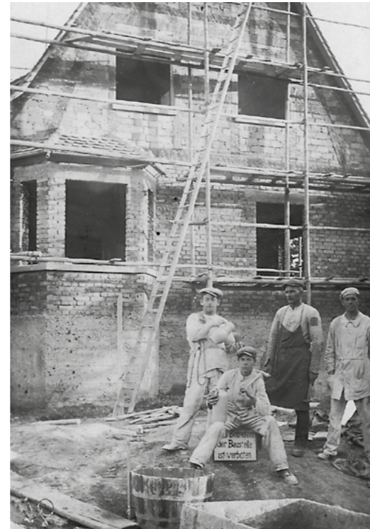
Plattenhardter Bauhandwerker bei einer Baustelle in der Schillerstraße, 1920er Jahre.
