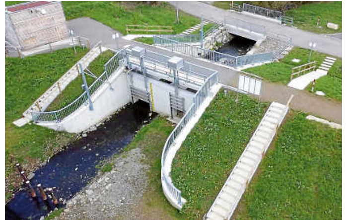
Zwei Maßnahmen zum Schutz vor Starkregen in Bernhausen: links das Rückhaltebecken im Gebiet „Augenloch“ und rechts die Schutzmauer an der Rosenstraße.
